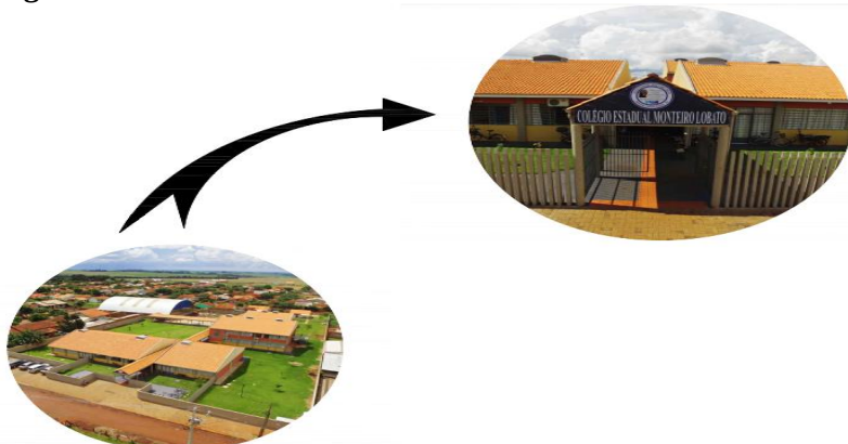
Figura 3: Visão aérea e fachada do local do estudo de caso.
