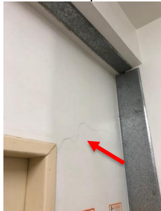
Fissura na parede
