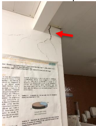
Fissura na parede
