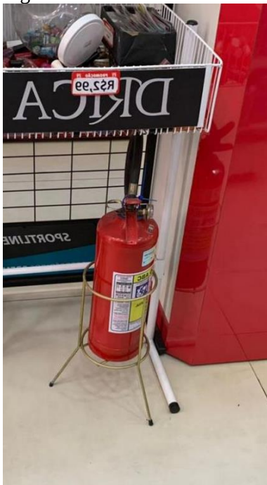
Figura 7 - Extintor sem demarcação do local onde deve ficar
