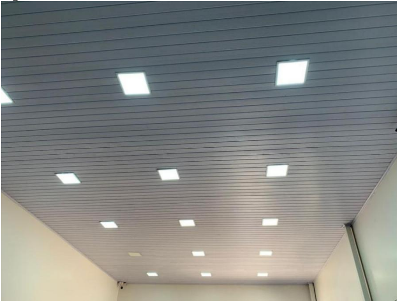
Figura 5 - Forro em PVC
