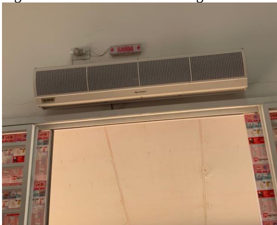
Figura 8 - Placa de saída de emergência
