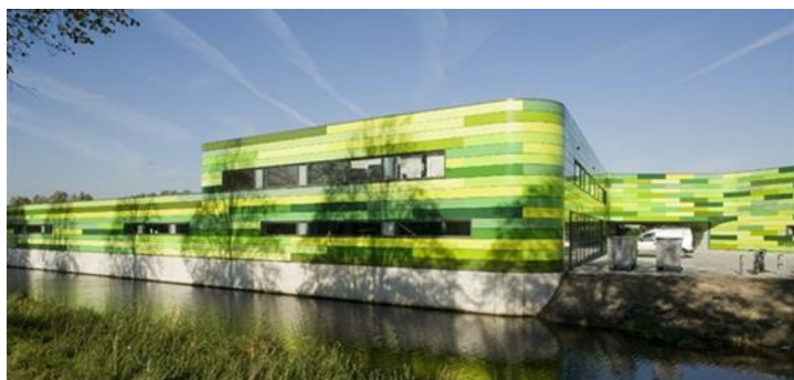
Figura 06 - Fachada do Animal Refuge Center
