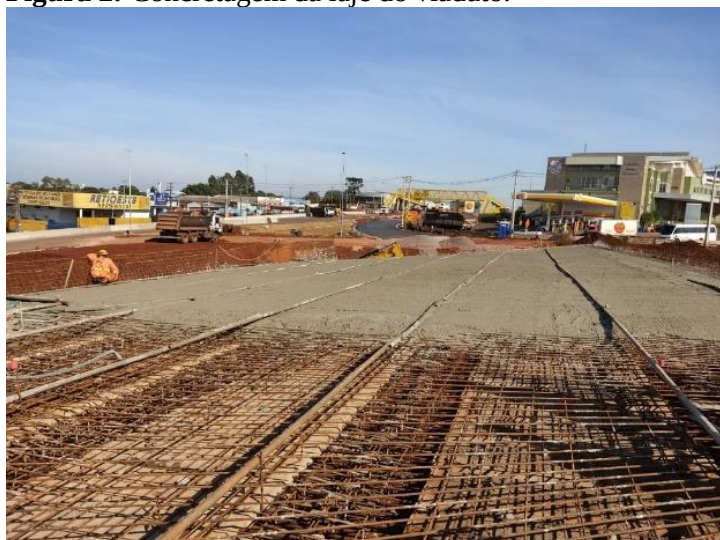
Figura 2: Concretagem da laje do viaduto.
