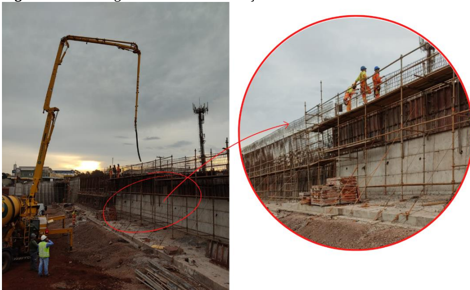
Figura 4: Concretagem do muro de contenção.
