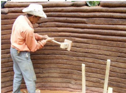
Figura 4 - Compactação Lateral Das Paredes.
