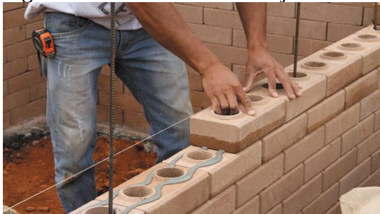
Figura 3 - Assentamento de Tijolo Solo-Cimento em Campo de Obra.
