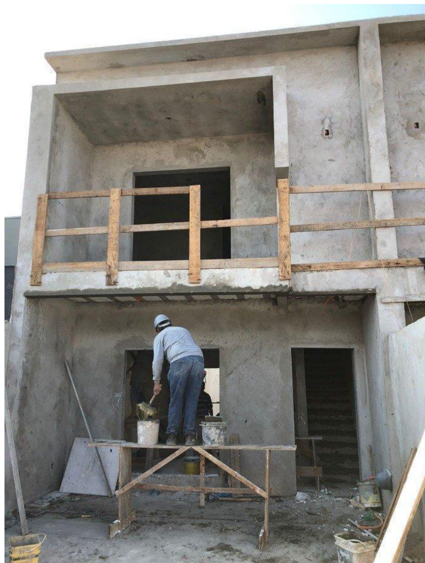
Figura 6: Retrabalhos sendo executados em obra 02
