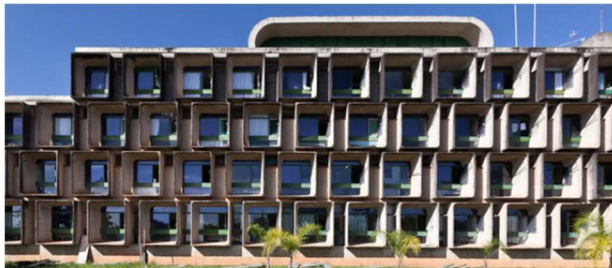
Figura 09: Vista Fachada detalhes das esquadrias
