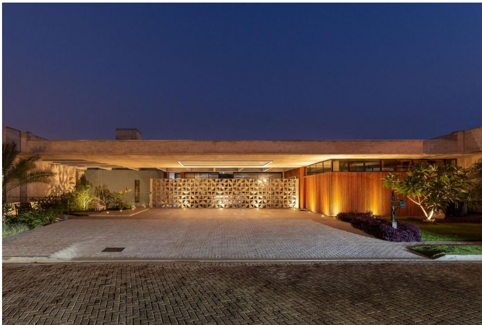
Figura 01 - Fachada Casa BRJ
