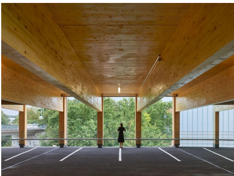
Figura 5- Perspectiva Interna Edifício Garagem Wendlingen
