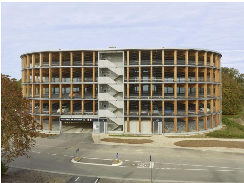
Figura 4 - Fachada Edifício Garagem Wendlingen
